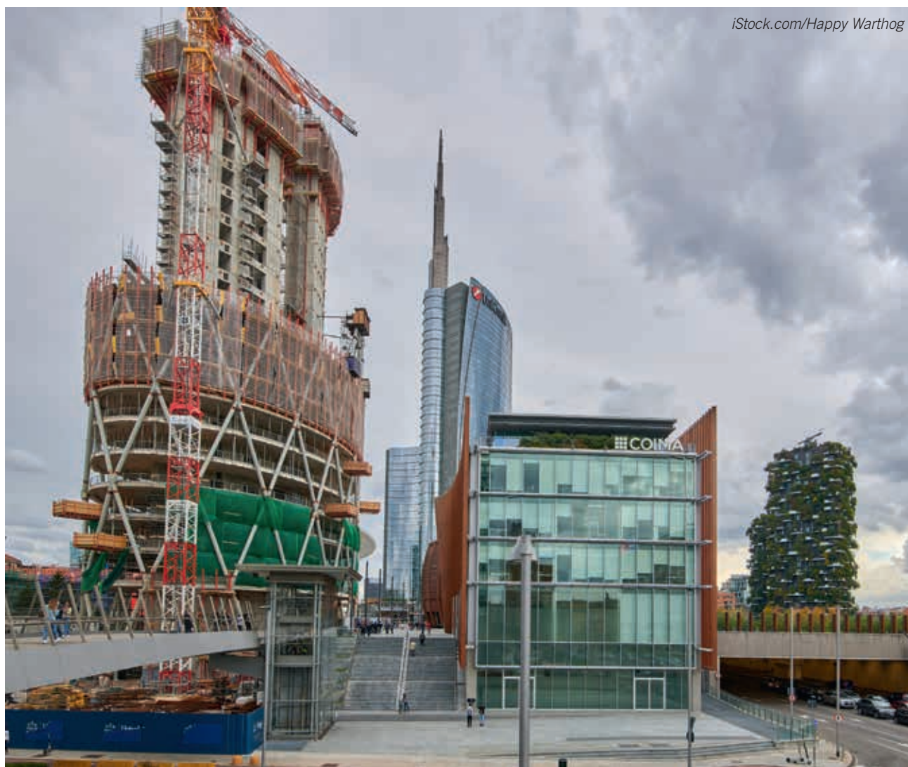
Il cantiere della Torre UnipolSai a Milano, costruita da Cmb e progettata da MC A
